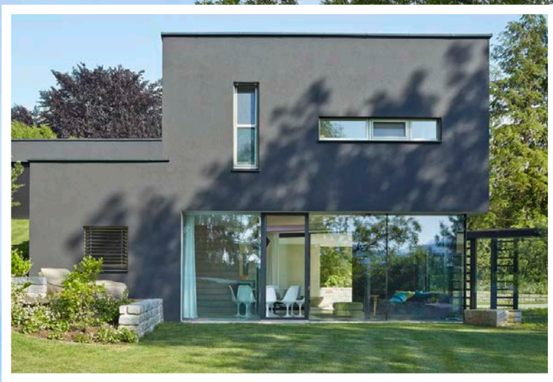
Ein Kontrapunkt zum Bestandshaus inklusive Verbindungsgang aus Glas
