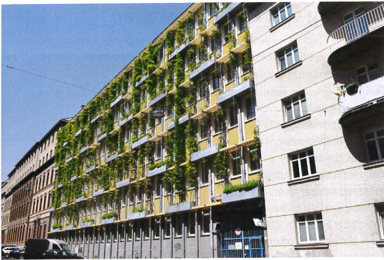
Begrünte Fassade der M31 in Wien.
